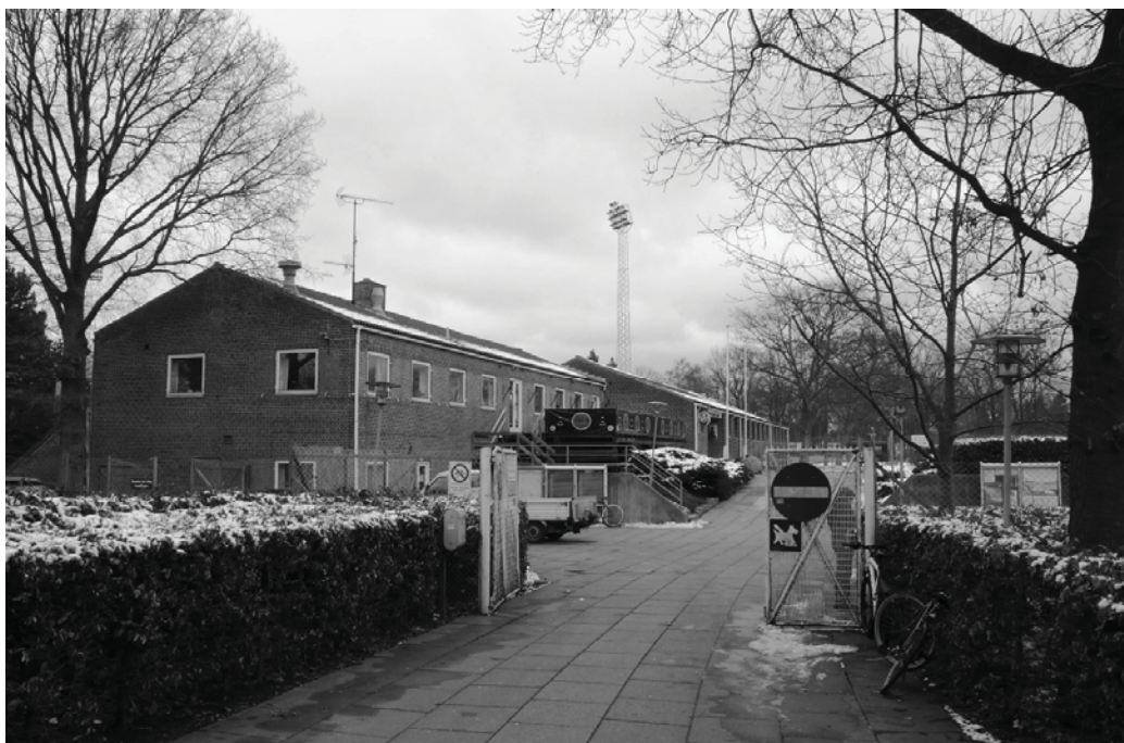
Gentofte Stadions klubhus er oprindeligt tegnet af arkitekt Arne Jacobsen. Senere er huset om- og tilbygget efter projekter af andre arkitekter og savner derfor den originalitet, der kunne begrundes, at bygningen i lokalplanen fastlægges med bevaringsbestemmelser.
